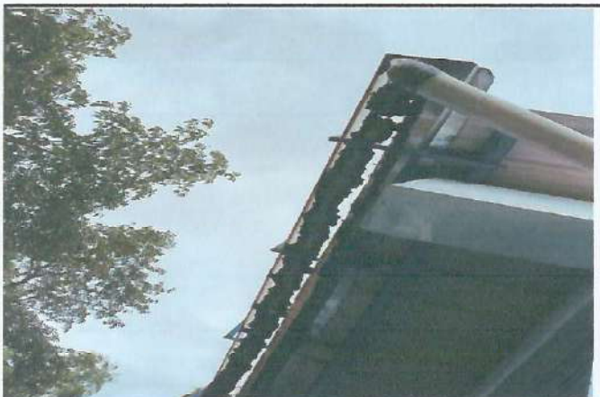
Foto 3: MEJORAMIENTO DE CANALETAS Y TUBOS PARA LA BAJADA PLUVIAL
