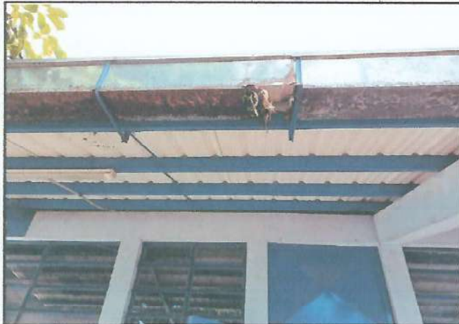
Foto 1: MEJORAMIENTO DE ESTRUCTURA DE TECHO
