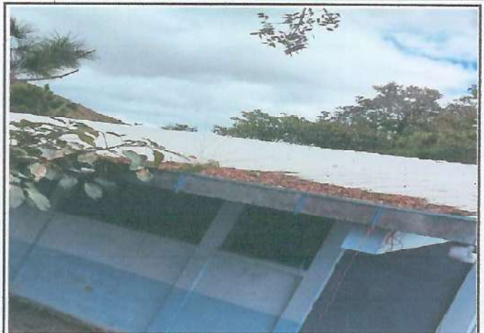
Foto 2: CUBIERTA DE LÁMINA TROQUELADA CALIBRE 26
